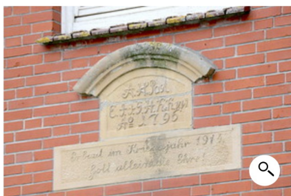
Der alte Stein, der an die Baujahre 1796 und zuletzt an das Baujahr des Gemeindehauses 1915 erinnert, soll wieder eingebaut werden. Foto: Böhmer
