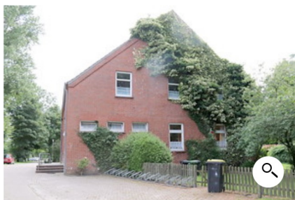
Dort, wo nun das Gemeindehaus steht, sollen 28 Parkplätze entstehen. Foto: Böhmer
