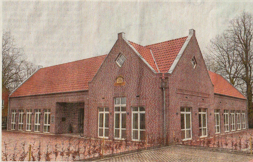
Das neue Victorburer Gemeindehaus wird im Februar eröffnet.
