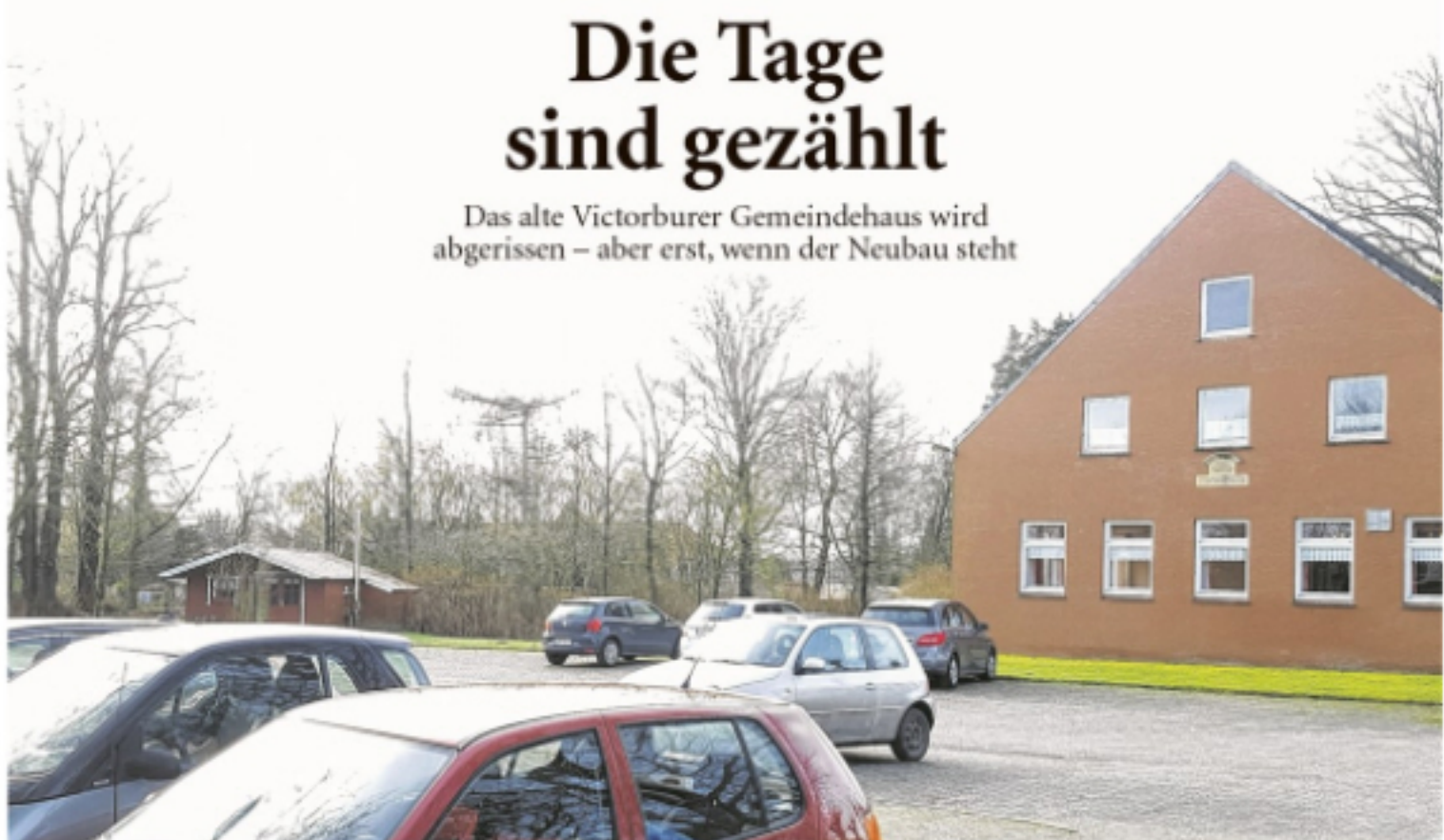
Wo jetzt noch Autos parken, soll bald das neue Victorburer Gemeindehaus entstehen. Das alte Gebäude wird anschließend abgerissen.
