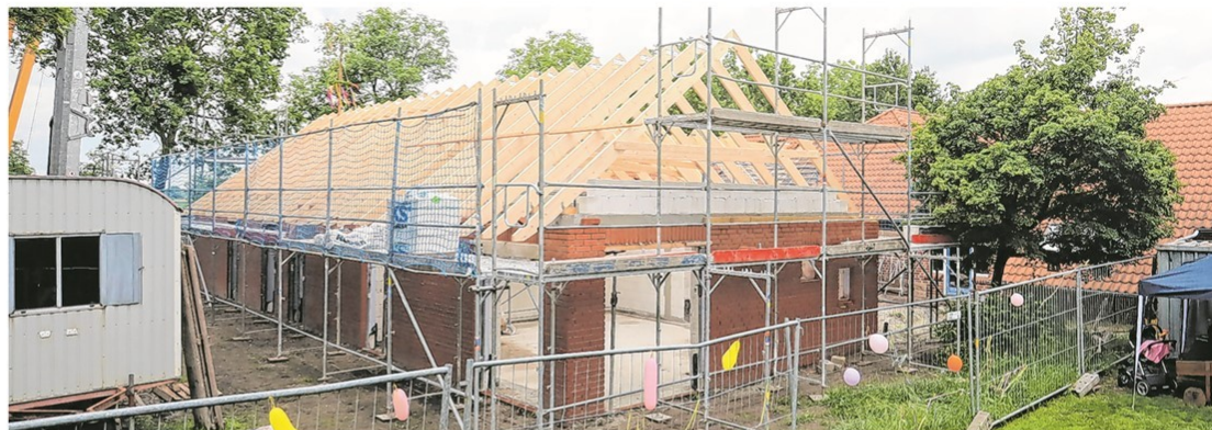
Laut der ursprünglichen Planung hätten die Arbeiten am Anbau in Victorbur schon viel weiter sein sollen.
