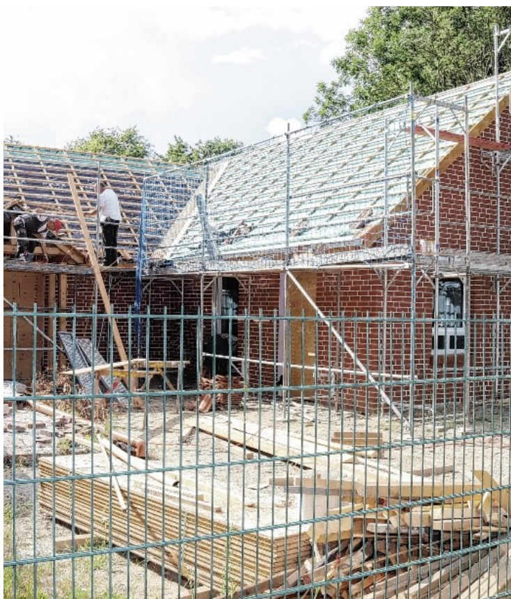
Fenster sind drin, die Fugen auch. Derzeit decken Handwerker das Dach. Fotos: Böhmer
